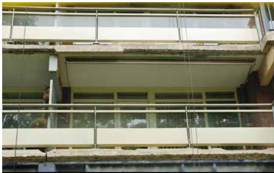
▲ Aanbrengen Kathodische bescherming
